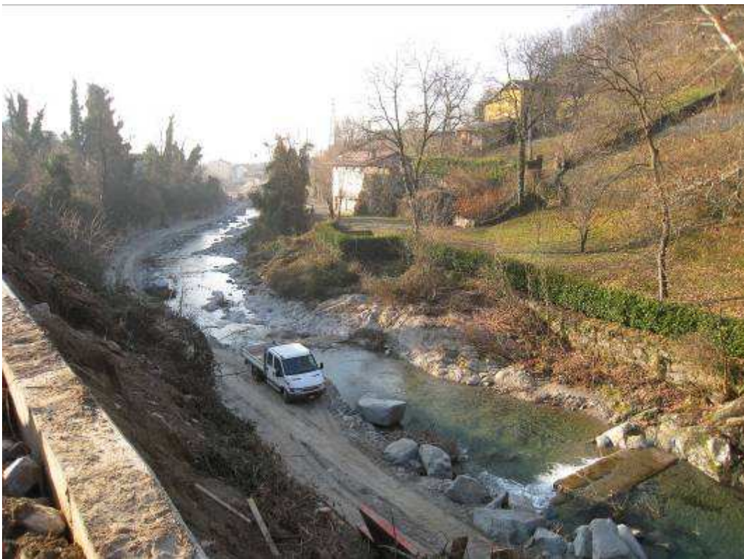
Foto 8 (095) – Vista verso valle dell'alveo del T.Liro: la soglia più a monte è la n.8
