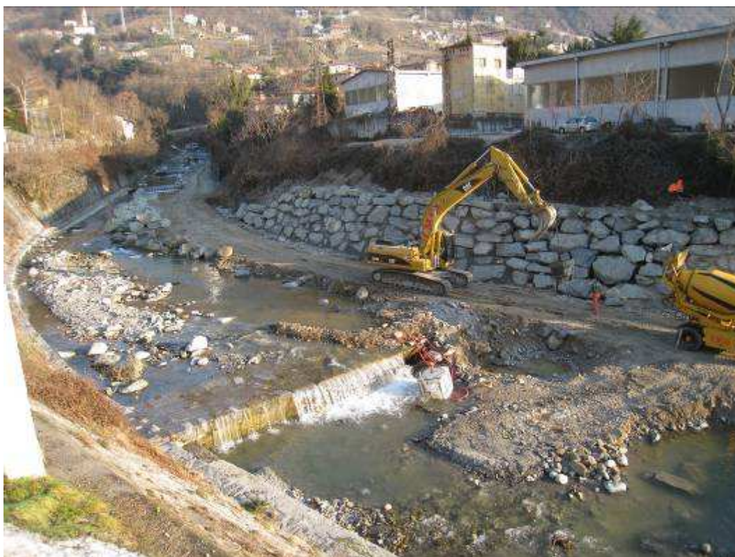
Foto 4 (056) – Vista verso monte dell'alveo del T.Liro: la soglia in primo piano è la soglia n.2
