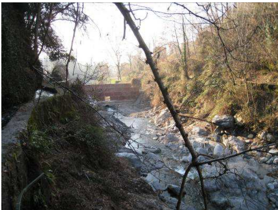
Foto 10 (113) – Vista verso valle del tratto di alveo del T.Liro a monte della briglia selettiva
