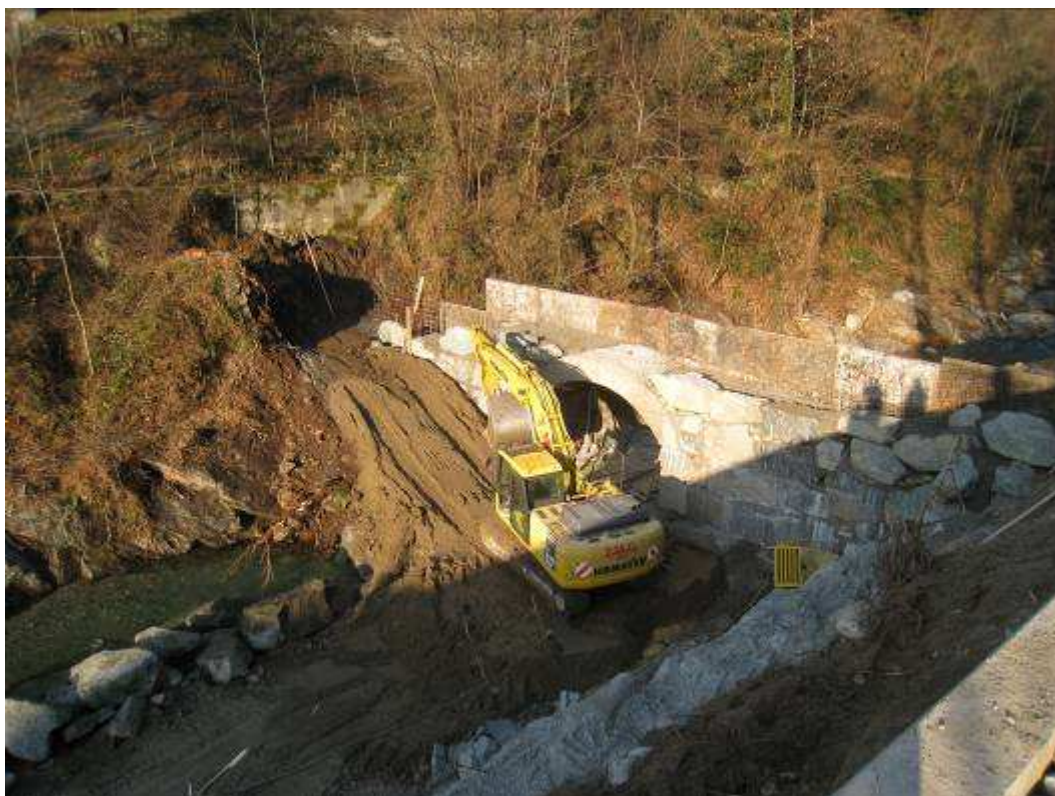
Foto 9 (096) – Briglia selettiva in costruzione
